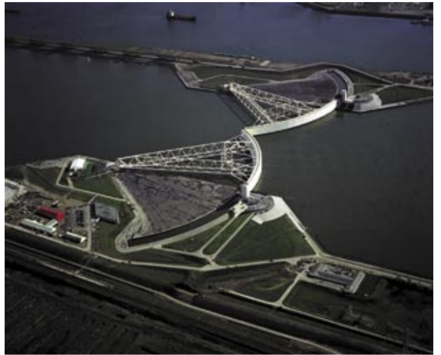
Gewaltige Stahlrohr-Arme halten den enormen Kräften des Wassers stand.
